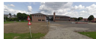
Brede School de Vogeltuyn (in aanbouw)
